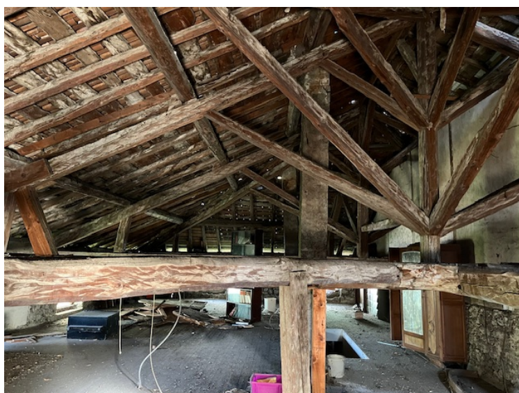
Toiture avec charpente à la française – mitoyenneté avec Maison Pélissier et riverain
