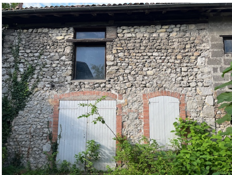
Annexe - étage accessible sur RD90
