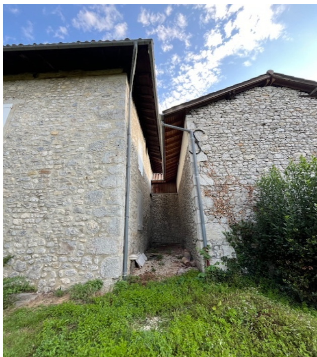
A gauche façade Pradourat – à droite façade Pélissier
