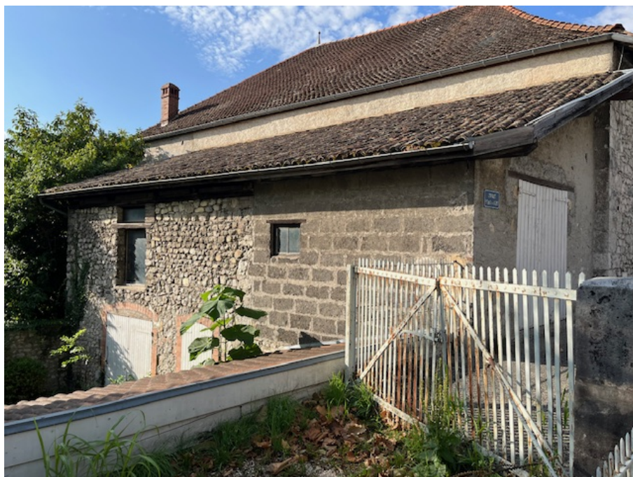
Annexe avec étage accessible via RD90
