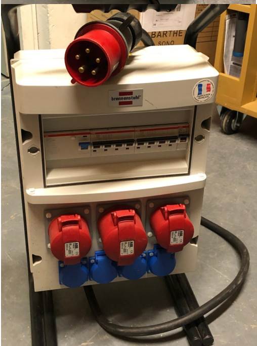
Coffret électrique 380 V, 32 ampères
